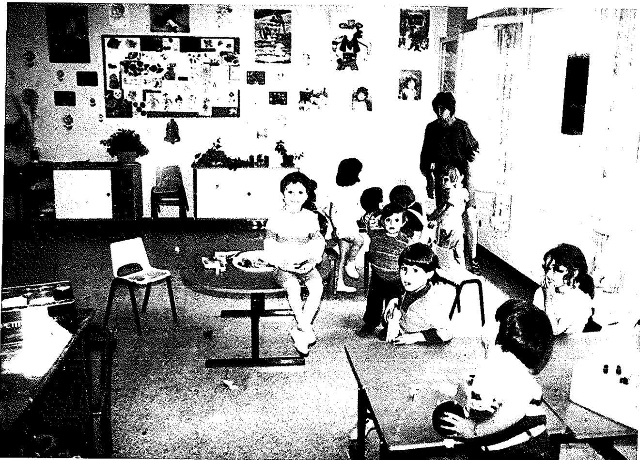
La classe maternelle après rénovation.
