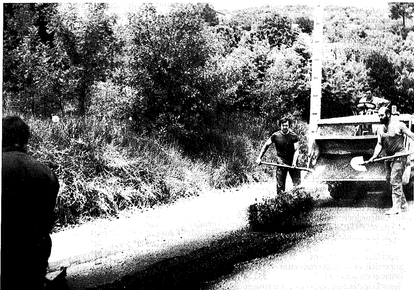
La remise en état de la chaussée marque la fin des travaux.
